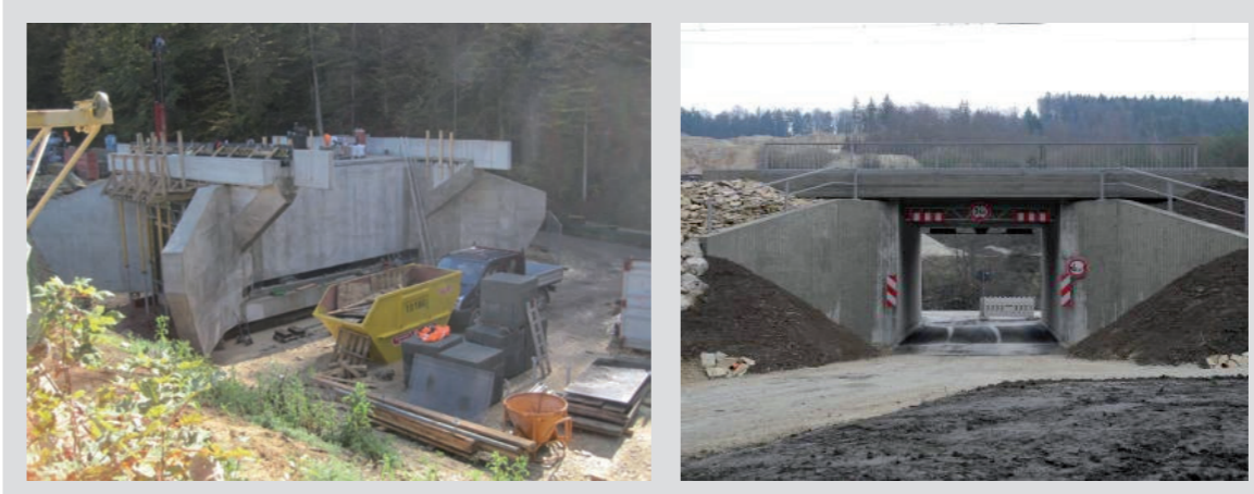
Abb. 3: Erstellung eines standardisierten Ersatzbauwerkes vor Ort (links) und Endlage nach Einschub des fertigen Bauwerkes (rechts), Quelle: Tristan Mölter, DB Netz AG
