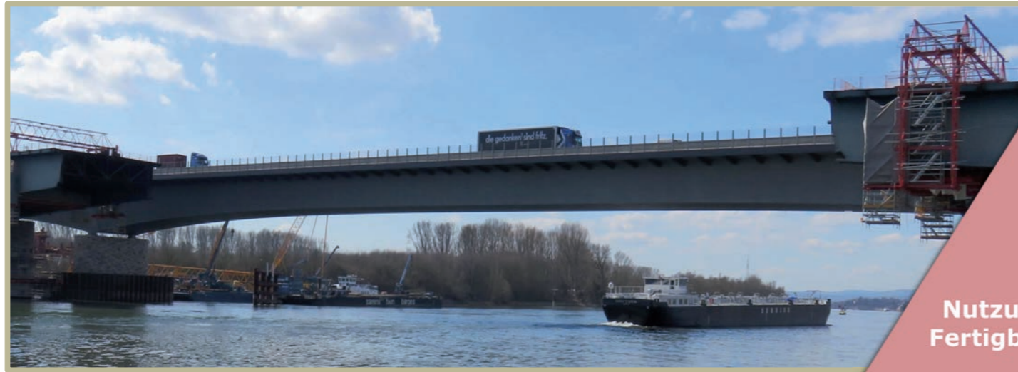
Abb. 1: Neubau im Rahmen des Ausbaus der Autobahn-Rheinbrücke Wiesbaden-Schierstein (Quelle: BAW)
