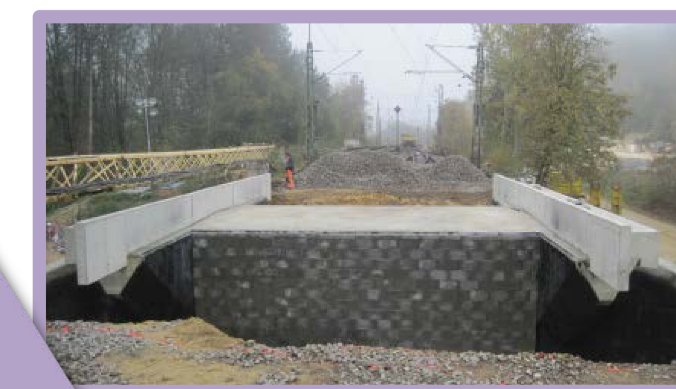
Abb. 2: (oben und unten) Ver- schub einer Vor-Ort erstellten Eisenbahnbrücke durch Pressen in die Endlage (Quelle: DB Netz AG, Tristan Mölter)
