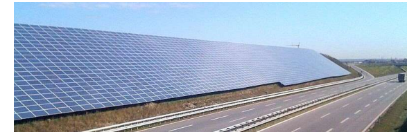
Abb.2: Photovoltaikmodule auf einem Lärmschuttwall. Quelle: BAST.
