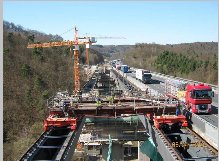
Beispiel Windelbachtalbrücke i.Z.d. A45 (Hessen)
