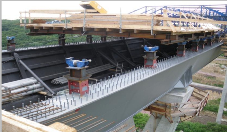
Nesselalbrücke im Zuge der A4
