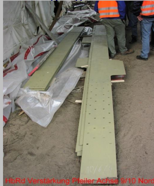
HbRd Verstärkung Pfeiler Achse 9/10 Nord
