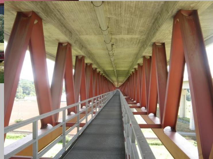
Itztalbrücke (NBS Erfurt – Nürnberg, 2004)
