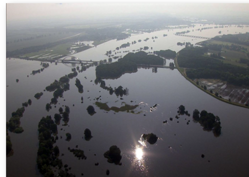
Abb. 3: Elbe Hochwasser 2013 (FGG Elbe)
