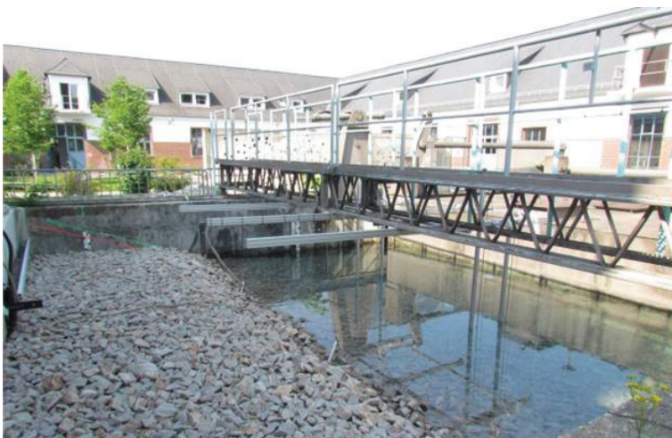
Abbildung 19: Wellengrube unmittelbar vor der Versuchsdurchführung.
