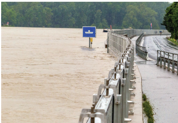
Abbildung 3-1: Temporäre Hochwasserschutzmaßnahmen können helfen hochwasserbedingte Schäden an der Verkehrsinfrastruktur zu reduzieren (Foto: Gina Sanders/Fotolia).
