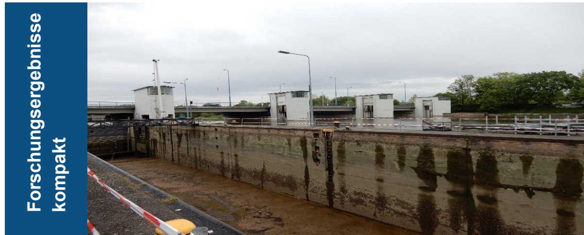
Abb. 1: Trockengelegte Schleusenammer der Schleuse Heilbronn am Neckar im Rahmen der Bauwerksinspektion 2019 (BAW 2019)
